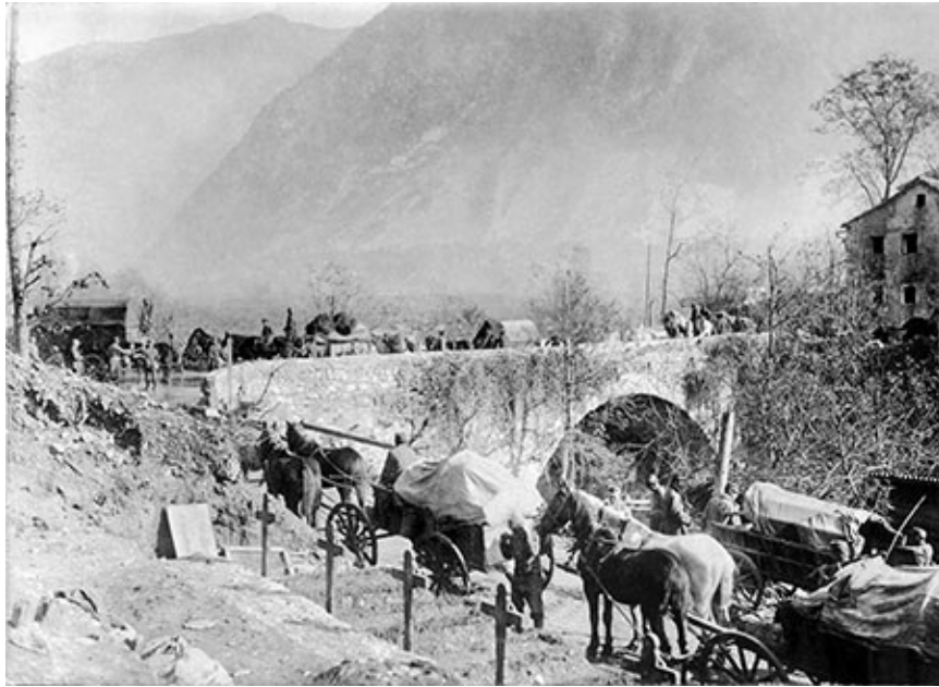
1. Companhia de manutenção austro-húngara, perto de Santa Lucia: “A trincheira propriamente dita fica bem em frente, com vista para o monte Santa Lucia, junto ao Isonzo. [...] Um vale profundo e íngreme separa as linhas italianas das austríacas, que se encontram na parte mais alta”.
